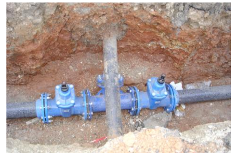
2- Pose d'une nouvelle canalisation d'eau potable
