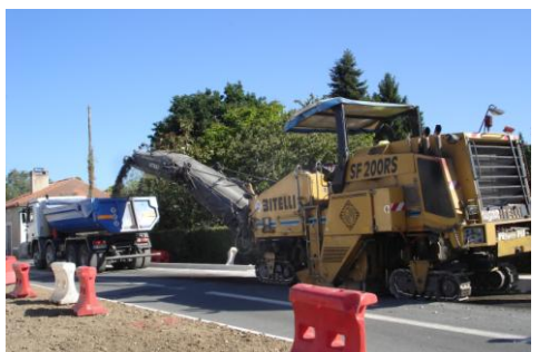
5- Rabotage de la chaussée avant la réalisation des trottoirs et du revêtement
