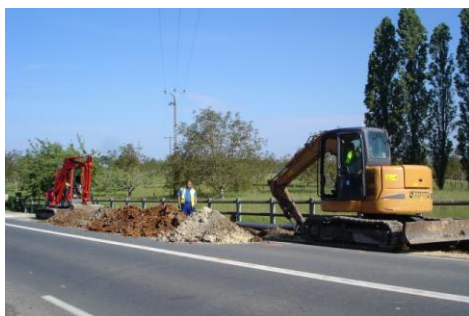
3- Mise en place d'un réseau de collecte des eaux pluviales
