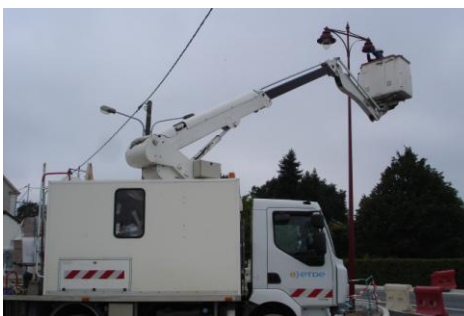
4- Installation de nouveaux candélabres et dépose des réseaux aériens et des supports
